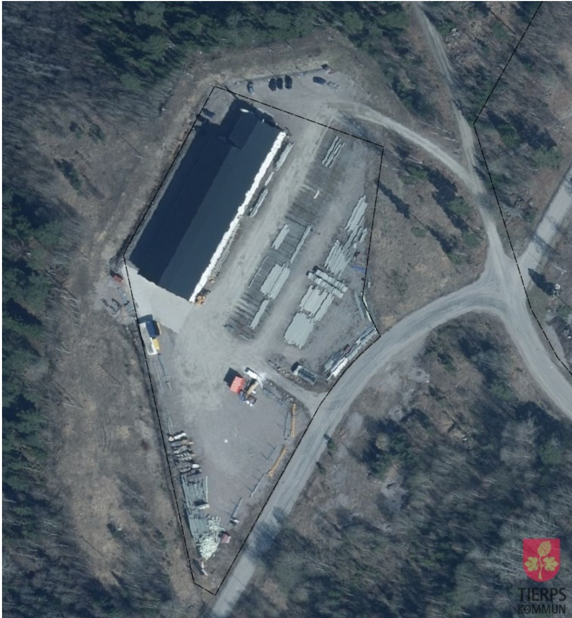
Figur 5: Foto som visar byggnad, upplag och parkering på Vallskoga 1:131, samt omkringliggande omgivning.
