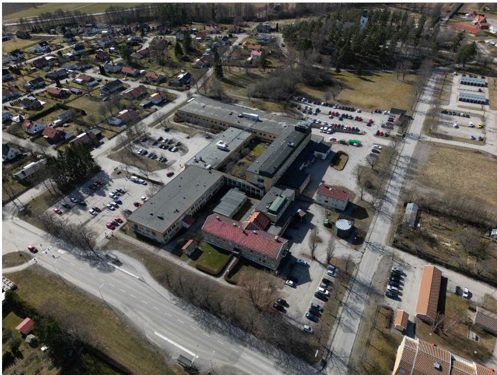
Figur 7: Översigtsbild över Tierps vårdcentrum sett från korsningen Uppsalavägen/Bergsgatan.
