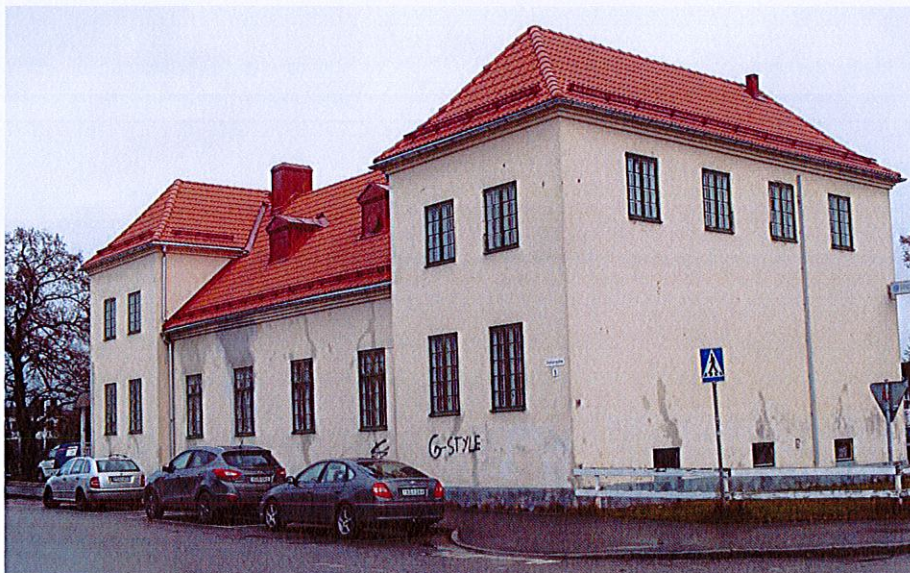
Fasad mot nordväst och sydväst. En strikt symmetrisk fönstersättning med småspröjsade fönster i en grön kulör som kontrast till den ljusgula slätputsen.
