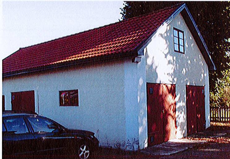
Uthusbyggnad på Tierp 24:4.
