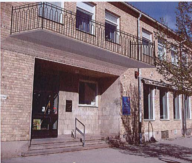
Exempel på utformning av ny balkong i tidstypisk (tidig) 50-tals arkitektur. Exemplet är från hämtat från det samtida f.d. kommunhuset i Edvalla uppfört 1949.
