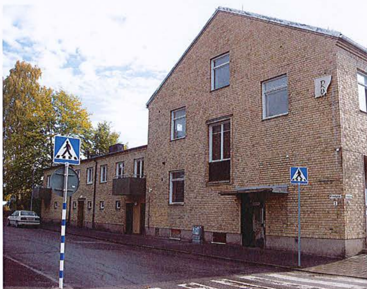
Byggnaden som varit postkontor på fastighet Tierp 25:5, fasad en längs Brunnsgatan.
