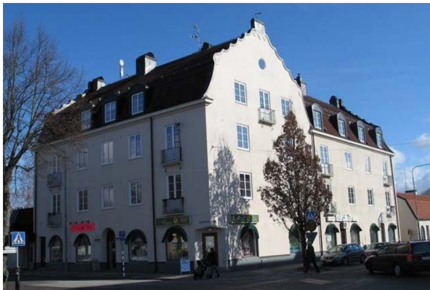
Figur 7: Bild av "Storhuset", beläget på fastigheten Tierp 87:2.
