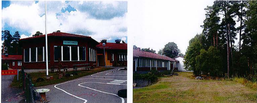
TV: Skolbyggnadens framsida sett från sydväst. TH: Område nordöst om skolan och väster om skogsområdet. Till höger i bild kan ett mer vildvuxet parti ansas. Detta är början på slätten som sluttar ner mot naturområdet och elljusspårerna. Bilen är tagen från ungefär den plats där närvärmeanläggningen planeras.
