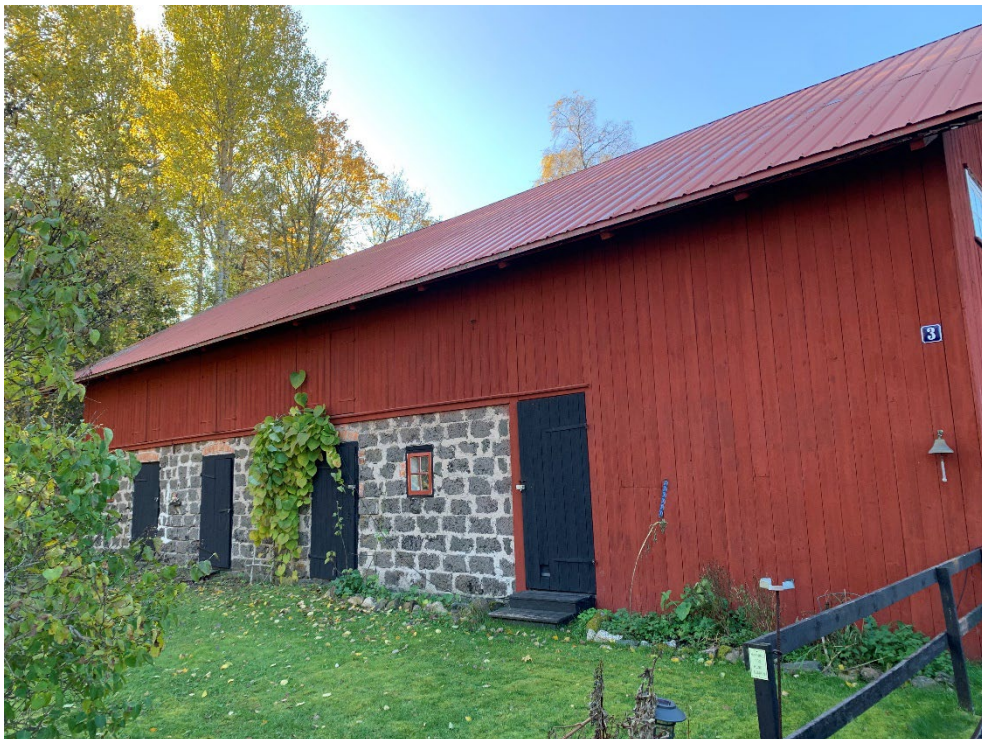
Figur 6. Fotot visar ladugårdsbyggnad uppförd på slaggstensgrund.
